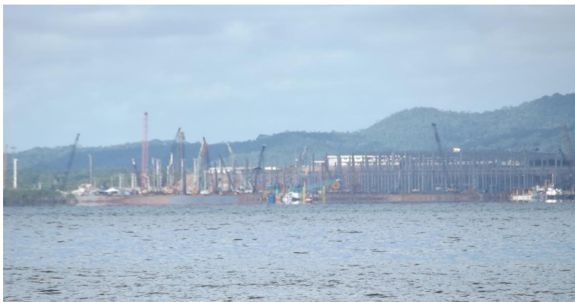
Figura 17: Canteiro de Obras São Roque do Paraguaçu. Foto: Luis Antonio P. Lima. 2013
