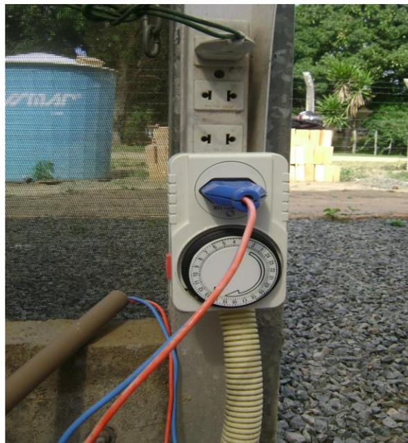
**Figura 33.** Temporizador analógico ligado à fonte de corrente elétrica.
