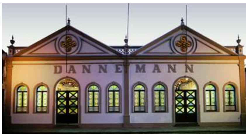
Figura 3.4-Fachada da fabrica Danneman, Cachoeira
