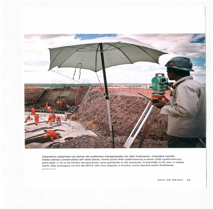
Figura 3.2 - Operários trabalhando no projeto
