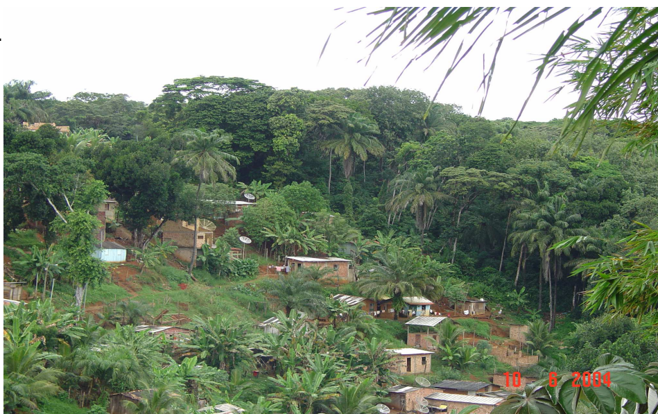
Figura 04: Construções de moradias em área de encosta com vegetação nativa
