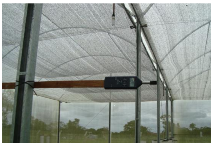
Figura 2. Termohigrômetro instalado no interior da casa-de-vegetação
