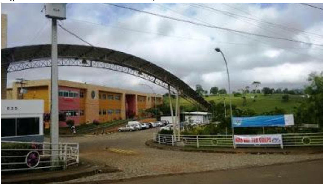
Figura 02 – Fachada do Centro de Formação de Professores - UFRB
