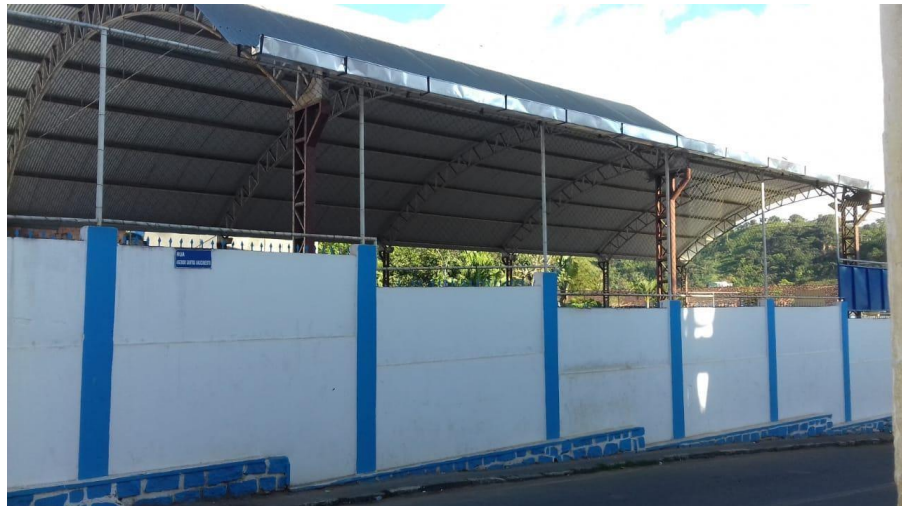
Figura 7 – Fachada da escola Flor de Laranjeira.
