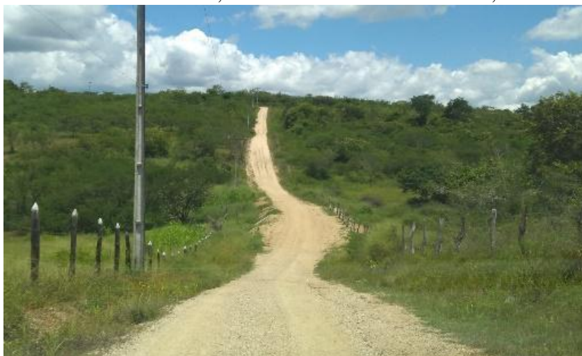
Figura 05. Único acesso com cascalhamento, na comunidade de Paus Altos, Antônio Cardoso – Ba
