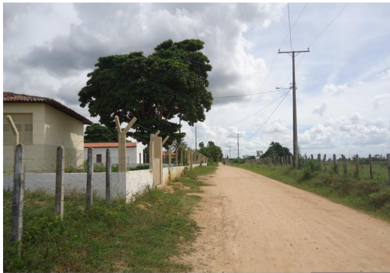
Figura 4 - Estrada que corta a comunidade
