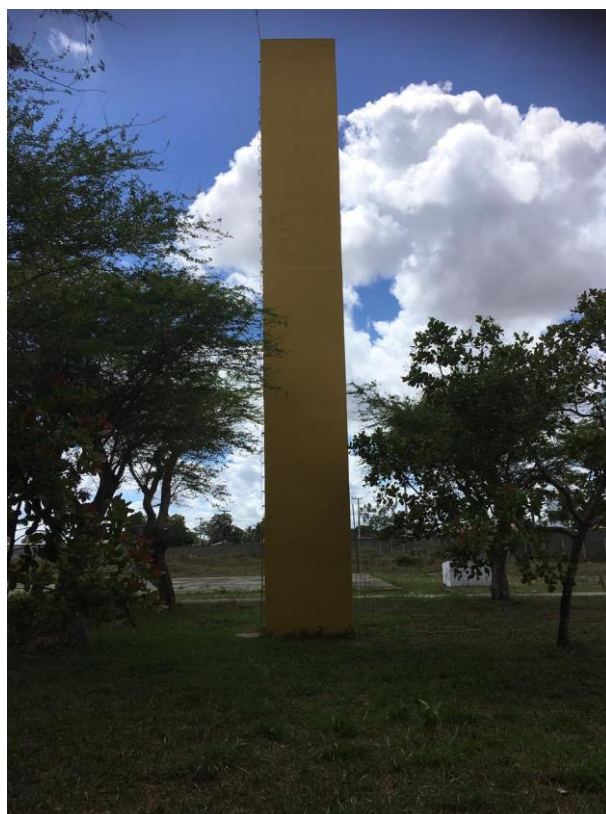
Figura 3.2 – Reservatório elevado do CETENS (Fonte: AUTOR, 2017)
