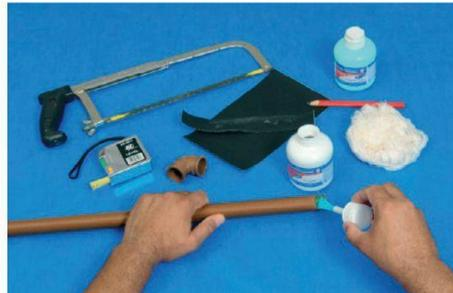
**Passo 4:** Encaixe de uma vez as extremidades a serem soldadas, promovendo, enquanto encaixar, um leve movimento de rotação de 1/4 de volta entre as peças, até que estas atinjam a posição definitiva. Remova o excesso de adesivo e espere 1 hora para encher a tubulação de água e 12 horas para fazer o teste de pressão.
