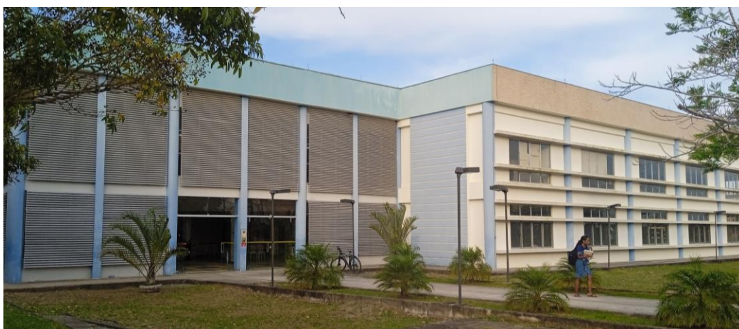
Figura 6 - Edificação da Biblioteca, UFRB, campus Santo Antônio de Jesus.
