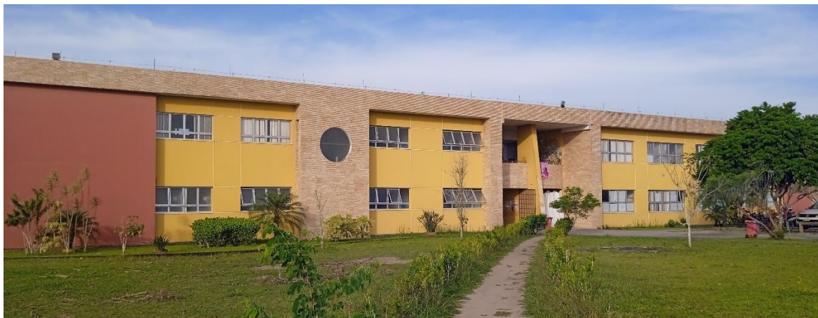
Figura 4 - Edificação do Pavilhão de Aulas I, UFRB, campus Santo Antônio de Jesus.
