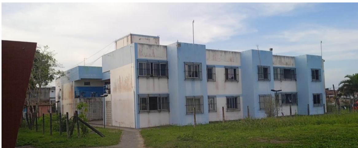
Figura 7 - Edificação da Residência Universitária, UFRB, campus Santo Antônio de Jesus.
