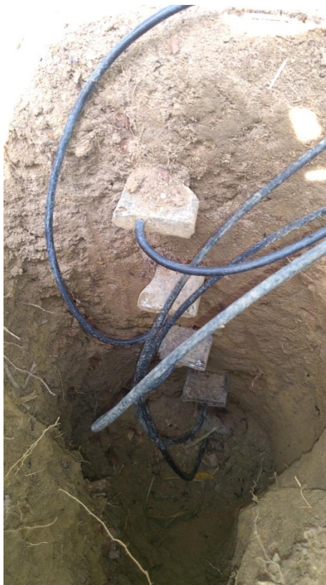
Figura 3. Instalação das sondas TDR em campo em cinco diferentes profundidades.
