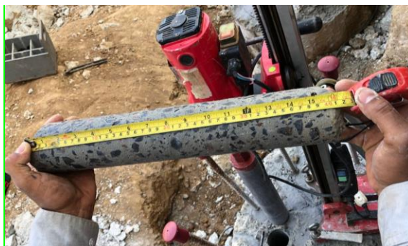
Figura 11: Extração realizada em uma estaca de concreto moldada in loco.
