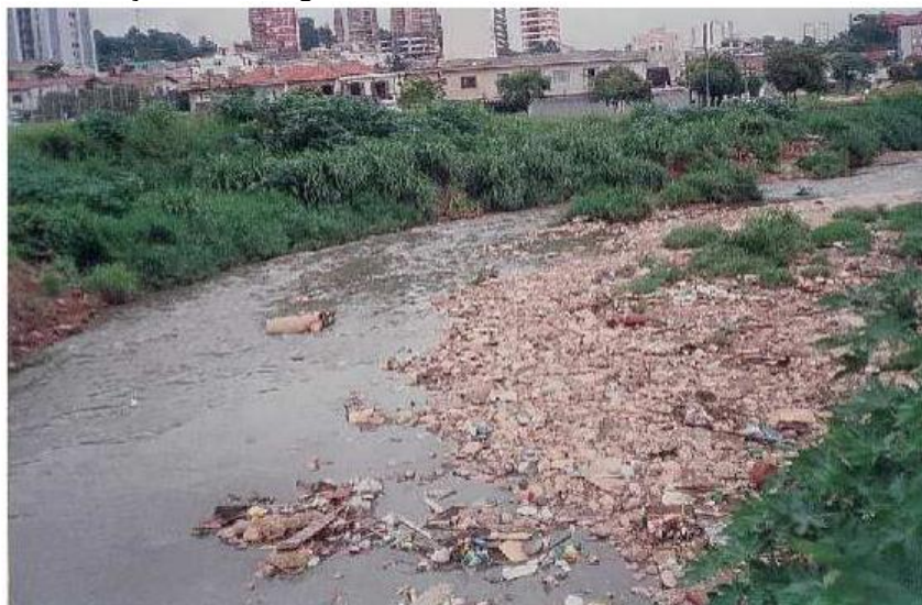
Figura 6-Obstrução do Córrego dos Meninos entre Santo André e São Bernardo-SP
