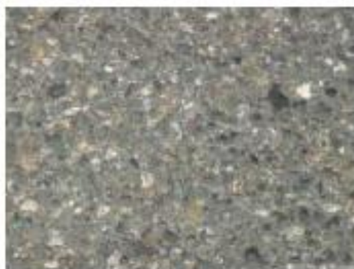
Figura 19: Degradação Inerte Polido
