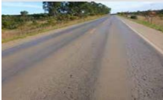
Figura 8: Deformação referente a grandes raios
