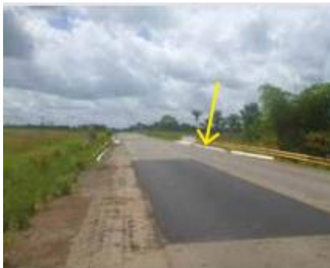
Figura 25: Remendo profundo
