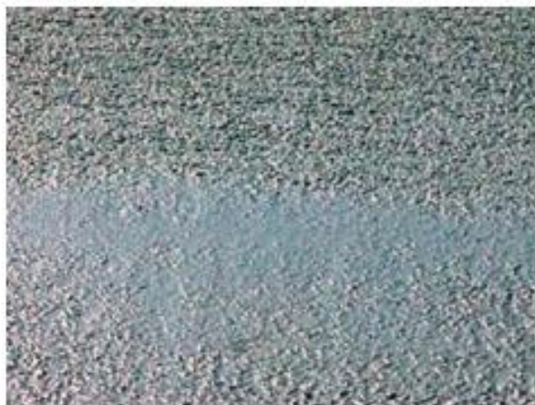
Figura 21: Movimento de materiais exsudação
