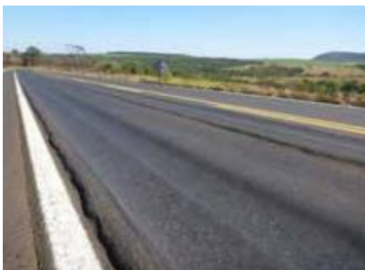
Figura 10: Deformação referente a pequenos raios
