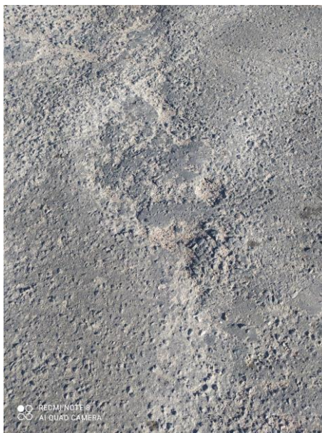
Figura 30: Desagregação superficial
