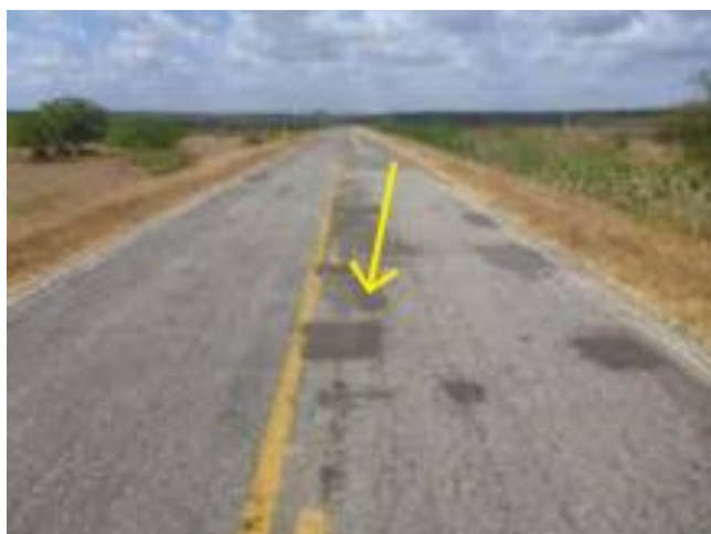
Figura 24: Remendo superficial
