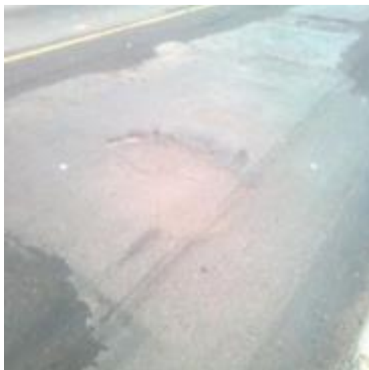
Figura 13: Deformação do tipo localizada
