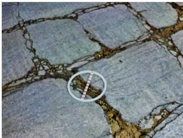
Figura 17: Fendas parabólicas/retração
