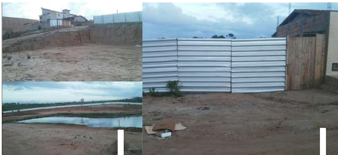
Figura 5: Fechamento, Intervenção (a) e Realização das Obras(b)
