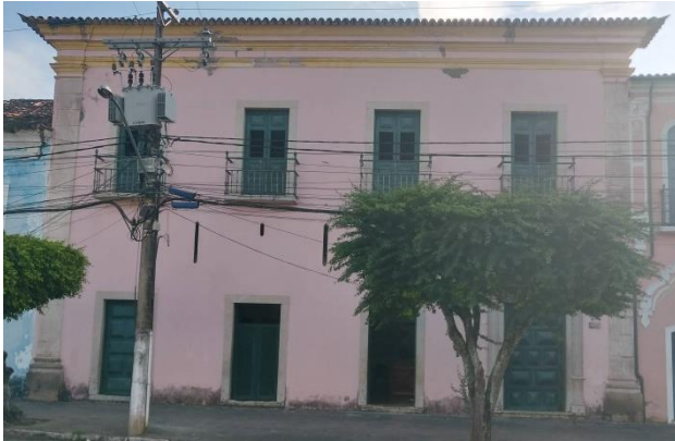
Figura 5 – Fachada frontal do sobrado
