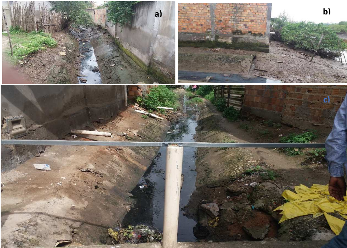
Figura 10. a) Canal de esgoto no bairro Trapiche de Baixo, cidade de Santo Amaro, 13 de julho de 2018; b) Canal de esgoto quando é lançado no rio Subaé, no bairro Trapiche de Baixo, cidade de Santo Amaro, 13 de julho de 2018; c) o esgoto das casas lançado ao, no bairro Trapiche de Baixo, cidade de Santo Amaro, Fonte: Arquivo da autora: 13 de julho 2018.
