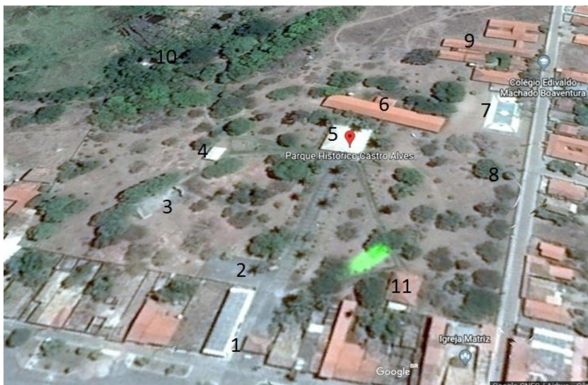
Figura 18: Observa-se as construções dentro do PHCA, onde classifica-se: 1) Guarita; 2) Estacionamento; 3) Anfiteatro; 4) Pouso de Adelaide; 5) PHCA; 6) Prédio anexo; 7) Quadra Poliesportiva; 8) Casa de Farinha; 9) Colégio Edivaldo Machado Boaventura; 10) Fonte de Água Doce; 11) Uma Casa da Administração. Na imagem não aparece a Cruz da Espada. Fonte: Google CNES/Airbus, 2019.
