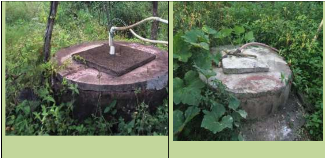
Figura 7: condições de conservação dos poços
