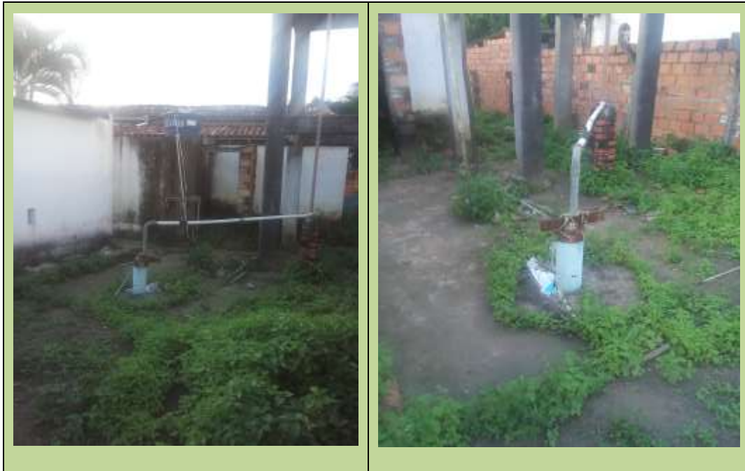
Figura 8: Condições do poço artesiano
