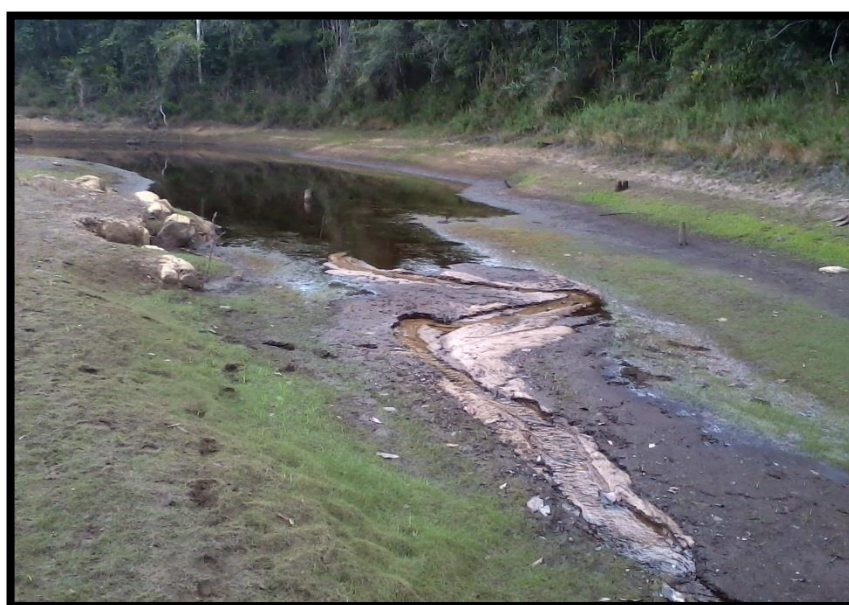
Figura 10 - Barragem vazia para limpeza, em março de 2013.
