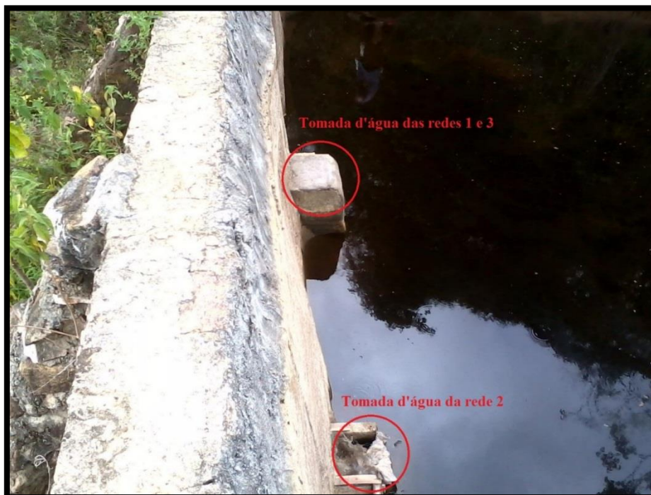
Figura 12 - Local da tomada d'água das redes na barragem do Braga, março de 2013.
