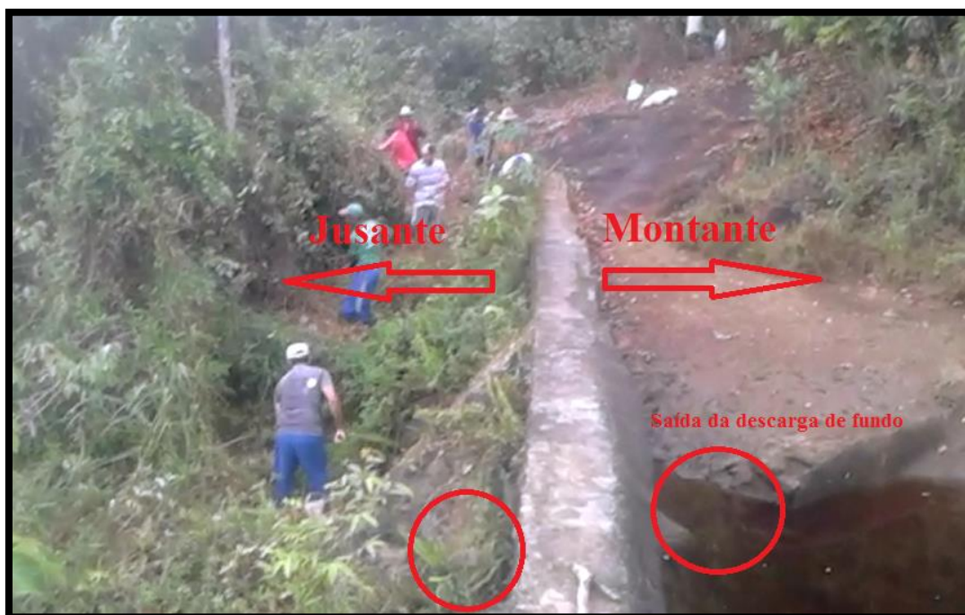
Figura 9 - Registro da limpeza da barragem e local da saída descarga de fundo.
