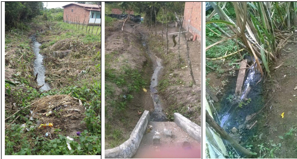
Drenagem de águas cinza e esgotos a céu aberto.
