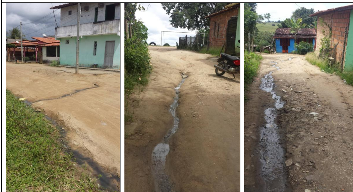
Vias públicas com lançamento de águas cinza.
