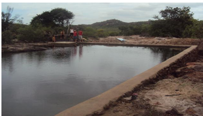
Figura 9 - Tanque de pedra
