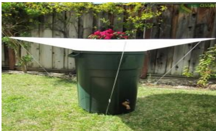
Figura 7 - Exemplo de superfície para captação de água de chuva
