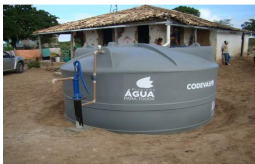
Figura 21 - Cisterna de PEAD utilizada pelo Programa Água para Todos
