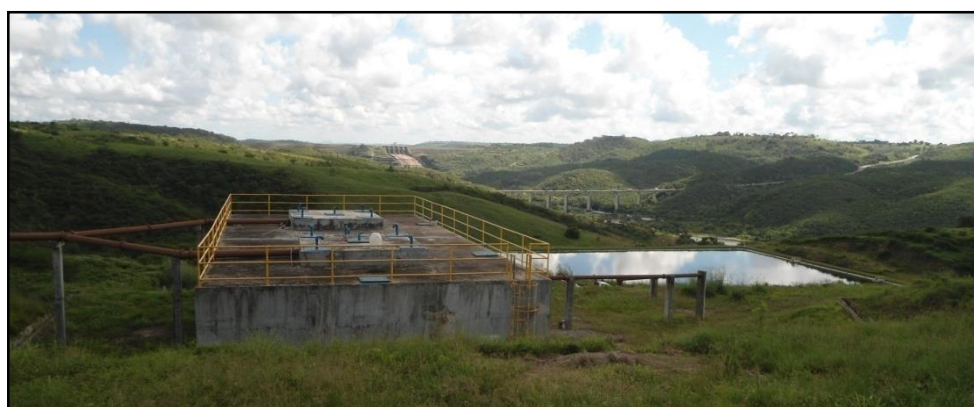
Figura 3. Estação de tratamento de esgoto da EMBASA/ Muritiba- BA.
