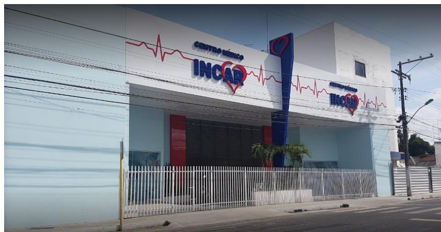
Figura 7. Entrada principal do Hospital Incar.
