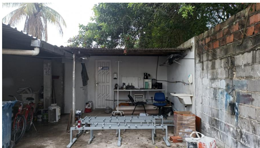
Figura 8. Sala do Setor de Manutenção.
