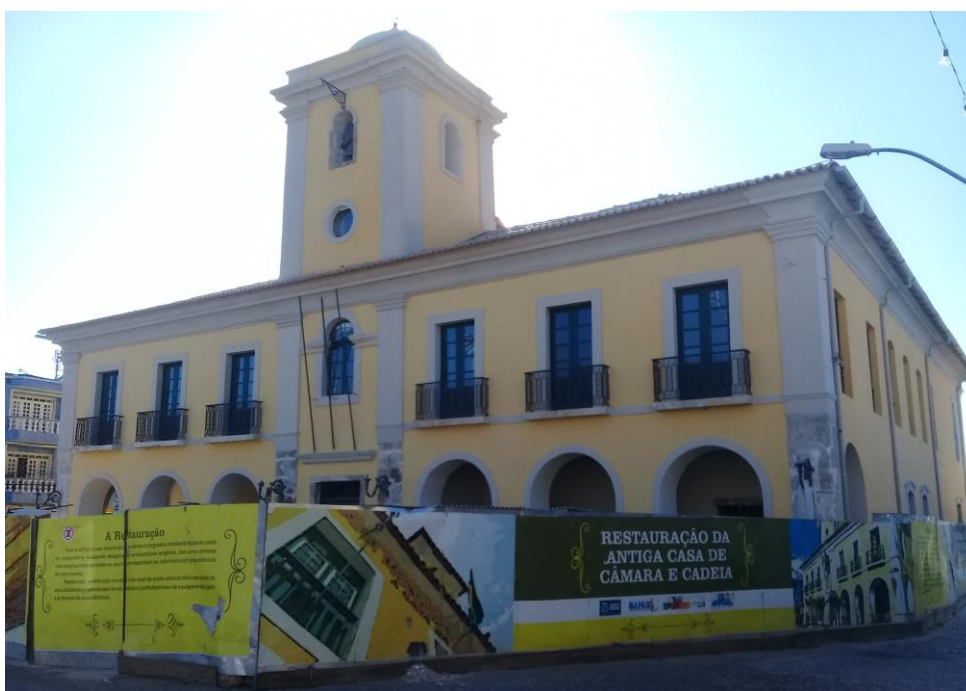
Fig. 22. Casa de Câmara, sob obras de restauração. (Foto de novembro de 2019. Acervo do Autor).
