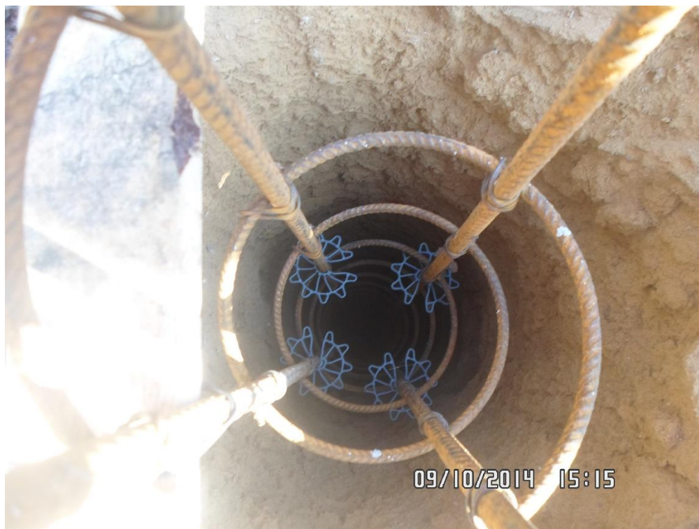
Figura 8: Instalação da armadura de estaca tipo broca
