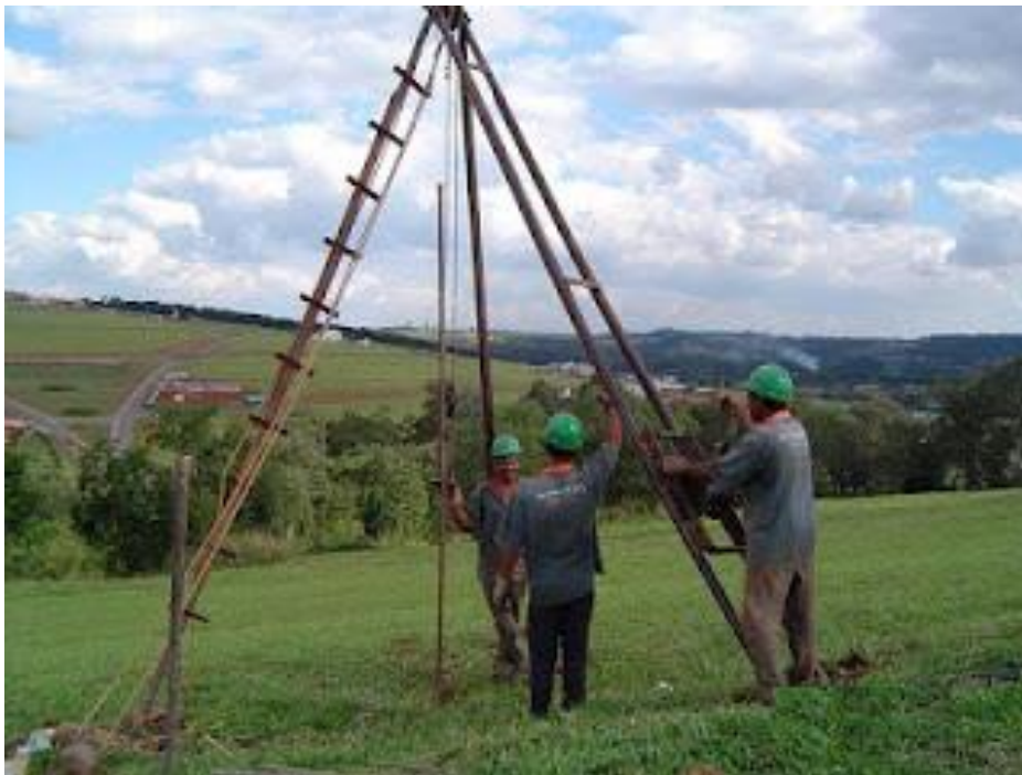
Figura 1: Sondagem a percussão
