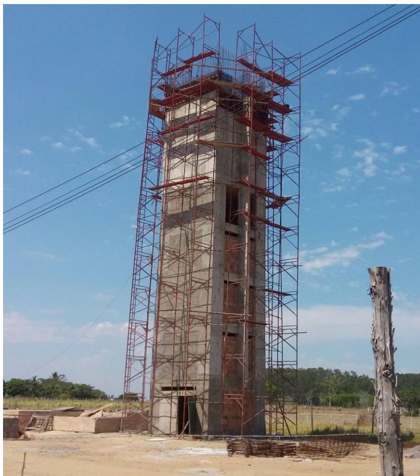
Figura 5: Processo de construção do castelo d'água
