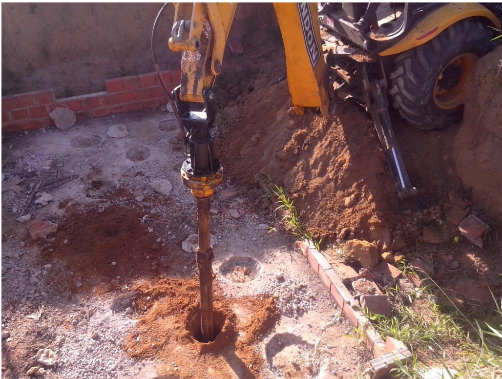
Figura 7. Perfuração de estaca tipo broca
