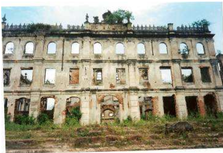
Figura 8. Ruínas da Imperial Escola Agrícola de São Bento das Lages (foto de 1993)
