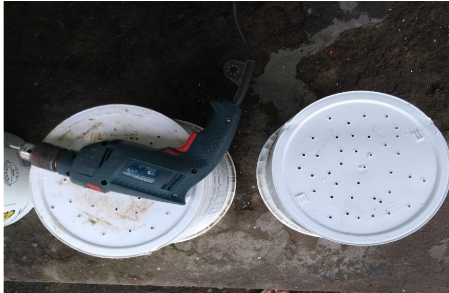
Figura 1: Detalhe do fundo dos baldes, onde foram feitos furos para drenagem.
