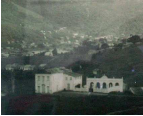
Figura 21: Vista panorâmica do cemitério dos Nagôs. Foto: Arquivo pessoal.
