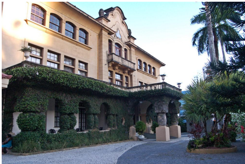
Figura 2 Fachada do Instituto Feminino da Bahia Fonte: < http://www.institutofeminino.org.br/ >
