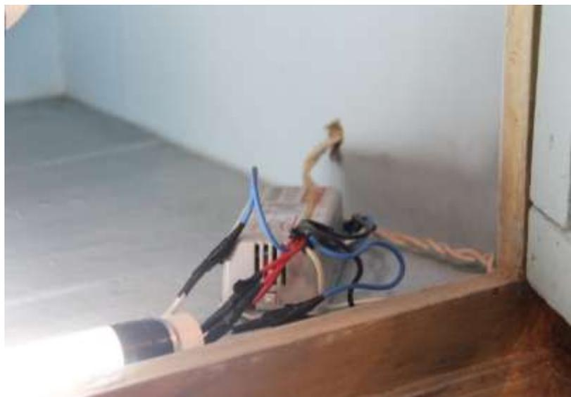
Fig. 10 – Reator em condições inadequadas dentro de um retábulo – Ano 2018
