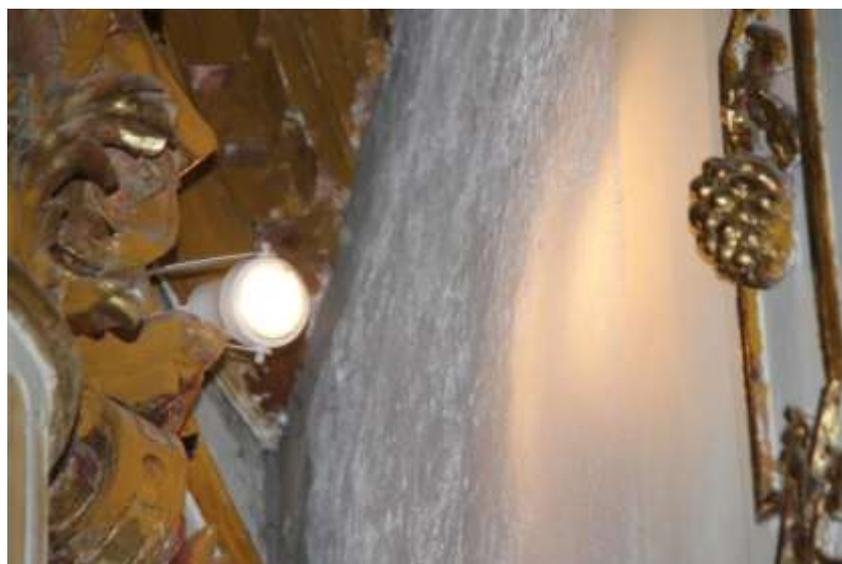
Fig. 11 – Lâmpadas inadequadas para madeira – Ano 2018
