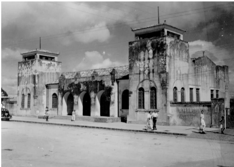
Figura 13- Antiga sede administrativa da balança do campo do gado prédio de 1942
