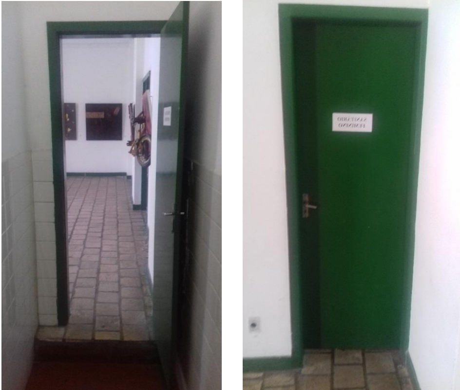
Figura 30- Portas de acesso ao banheiro do MAC com degrau dimensões 17 cm a 20 cm.
