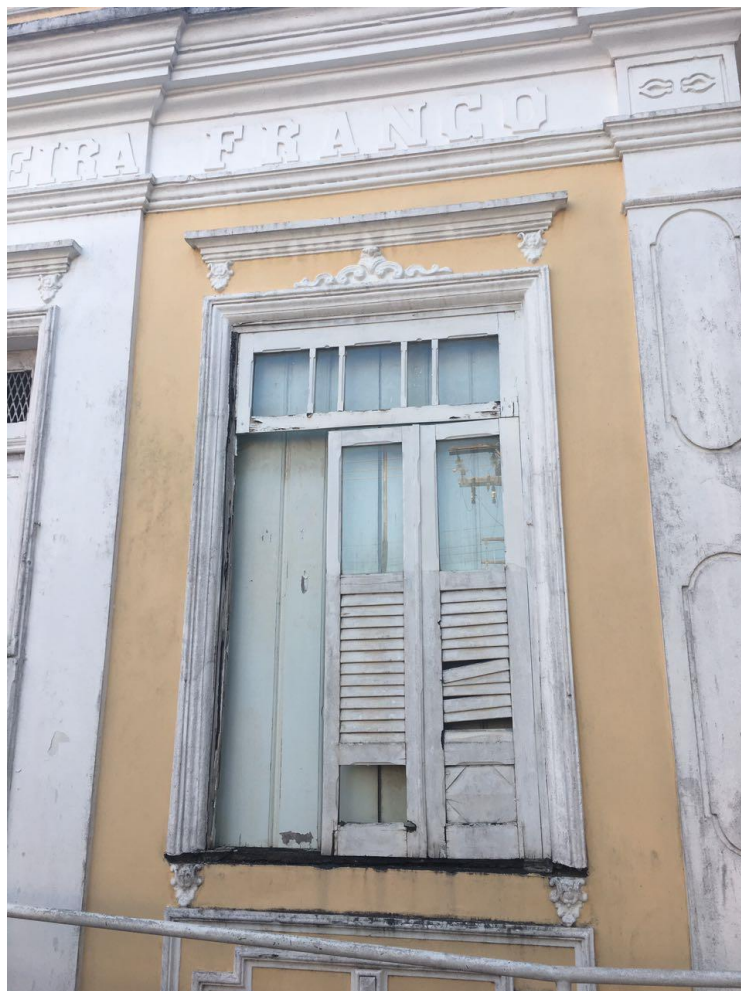
Figura 19: Janela da fachada do pavilhão anexo prédio da antiga escola normal.
