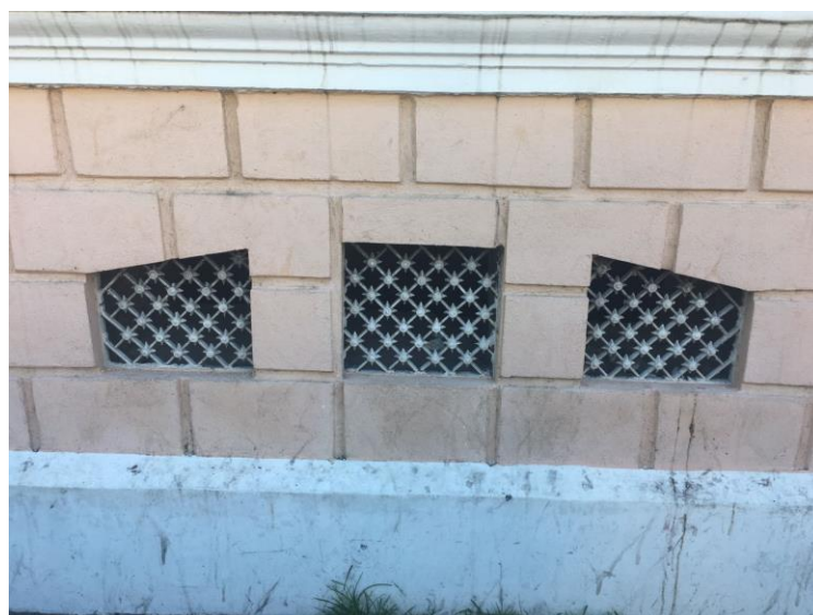
Figura 22: Imagem do gradil de ventilação do porão da antiga escola normal.
