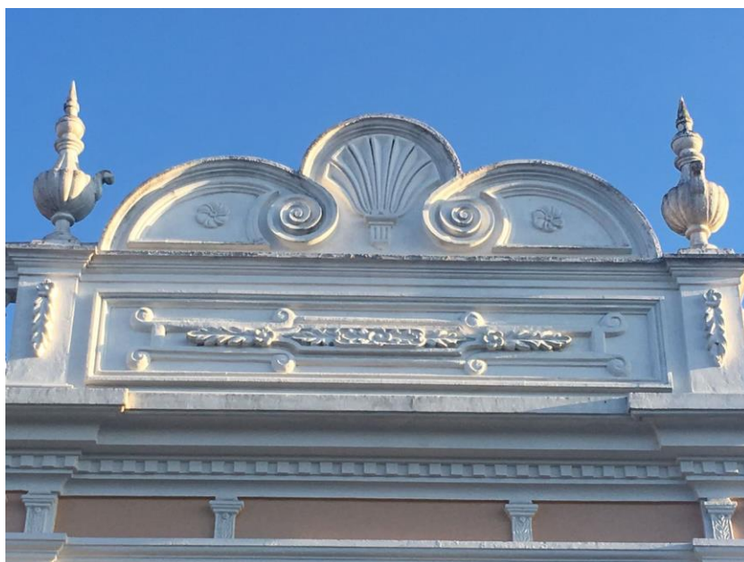
Figura 30: Adorno ao lado da balastrada localizado na parte superior do prédio.
