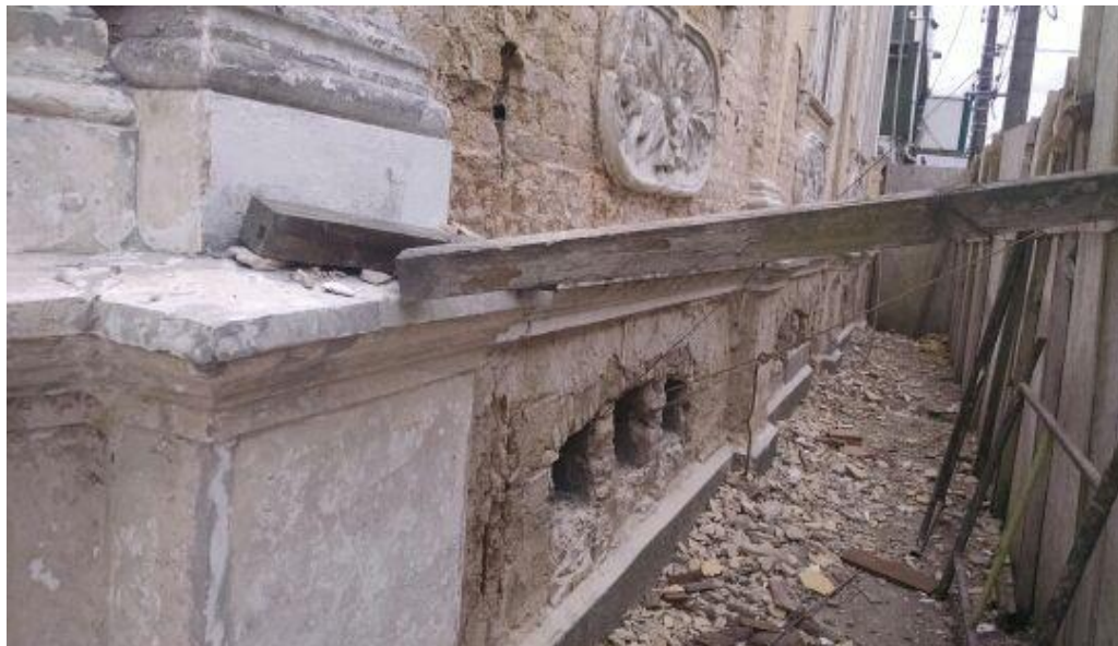
Figura 18: Imagem da fachada na reforma de 2013 podemos observar a retirada para reposição das argamassas.
