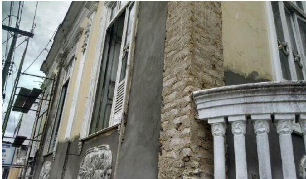
Figura 17: Imagem da fachada na reforma de 2013 podemos.
