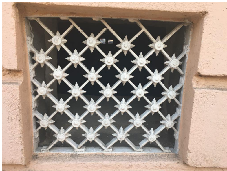
Figura 21: Imagem do gradil de ventilação do porão da antiga escola normal.
