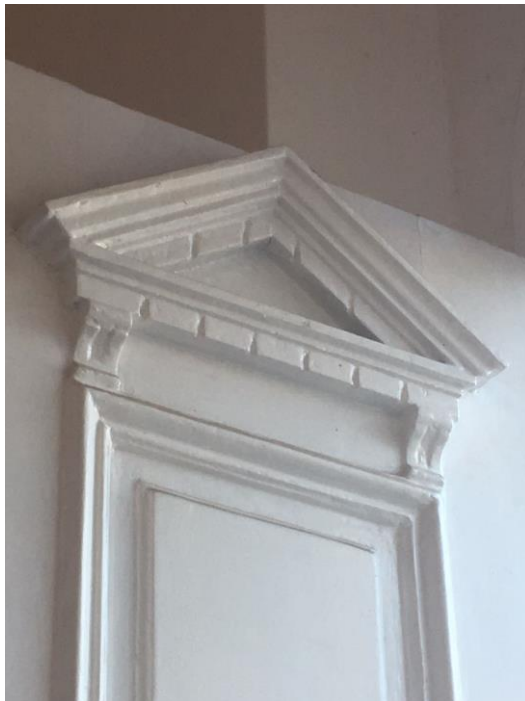
Figura 28: Vista da porta de entrada com aplique em madeira talhada e pintura esmalte sintético.
