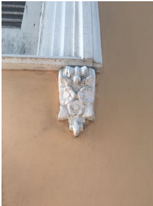
Figura 27: Adorno em alvenaria localizados abaixo das esquadrias.
