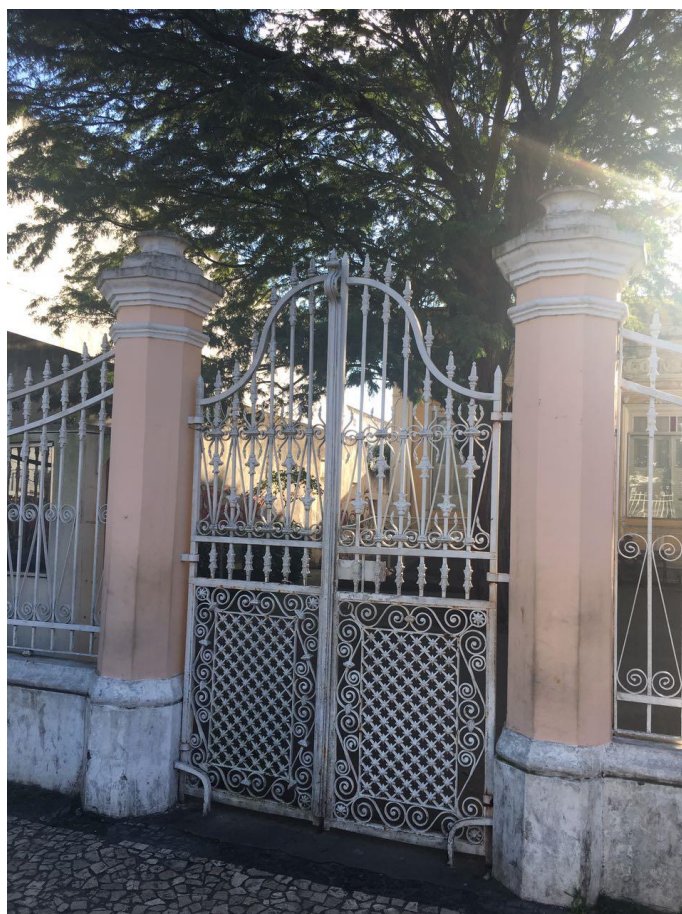
Figura 23: Portão de acesso lateral esquerda do prédio.
