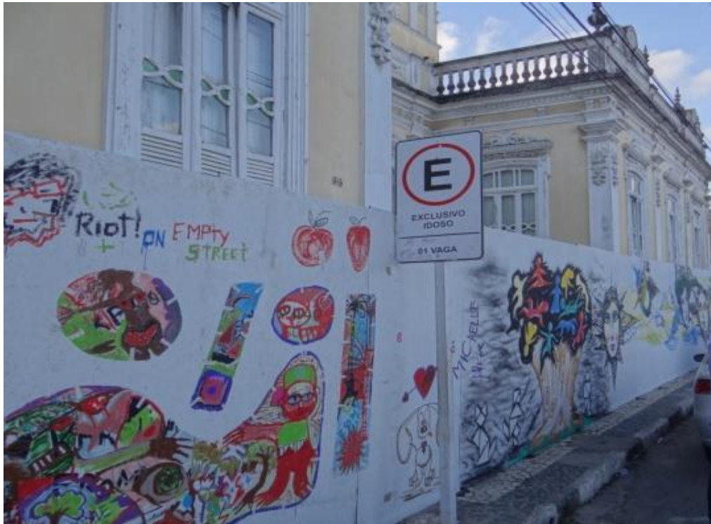
Figura 10: Fachada com madeirites para proteção e segurança.
