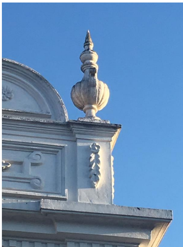
Figura 26: Pináculo na extremidade do prédio e calhas em alvenaria com frisos
