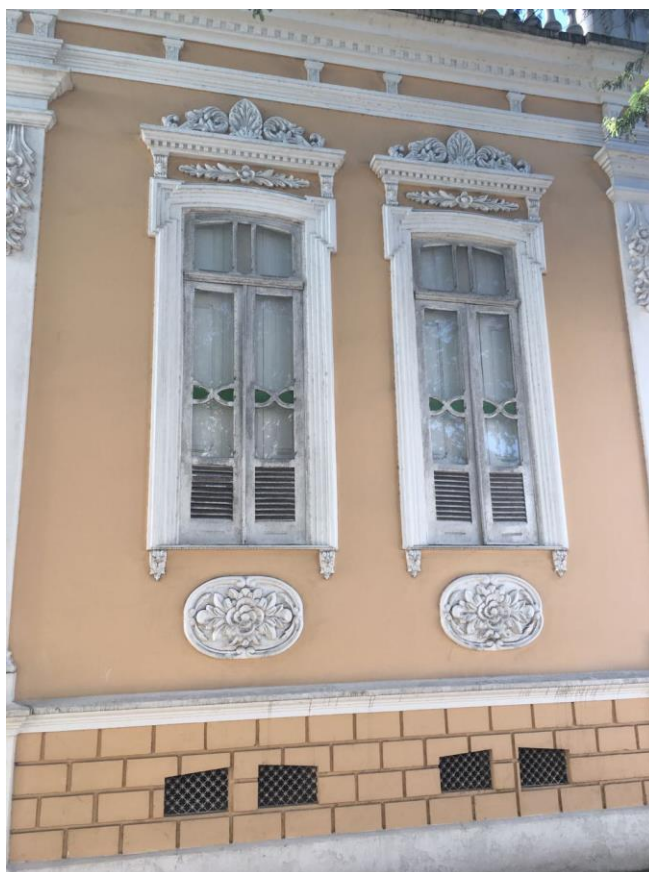
Figura 14: Janelas da fachada do prédio da antiga escola normal.
