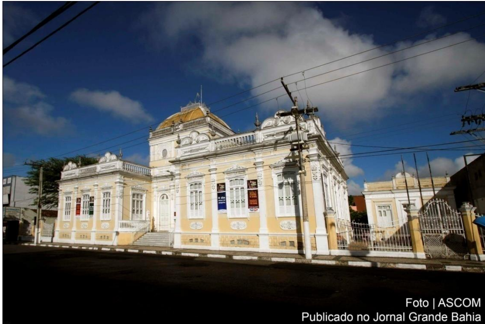
Figura 3: Foto atual da fachada.
