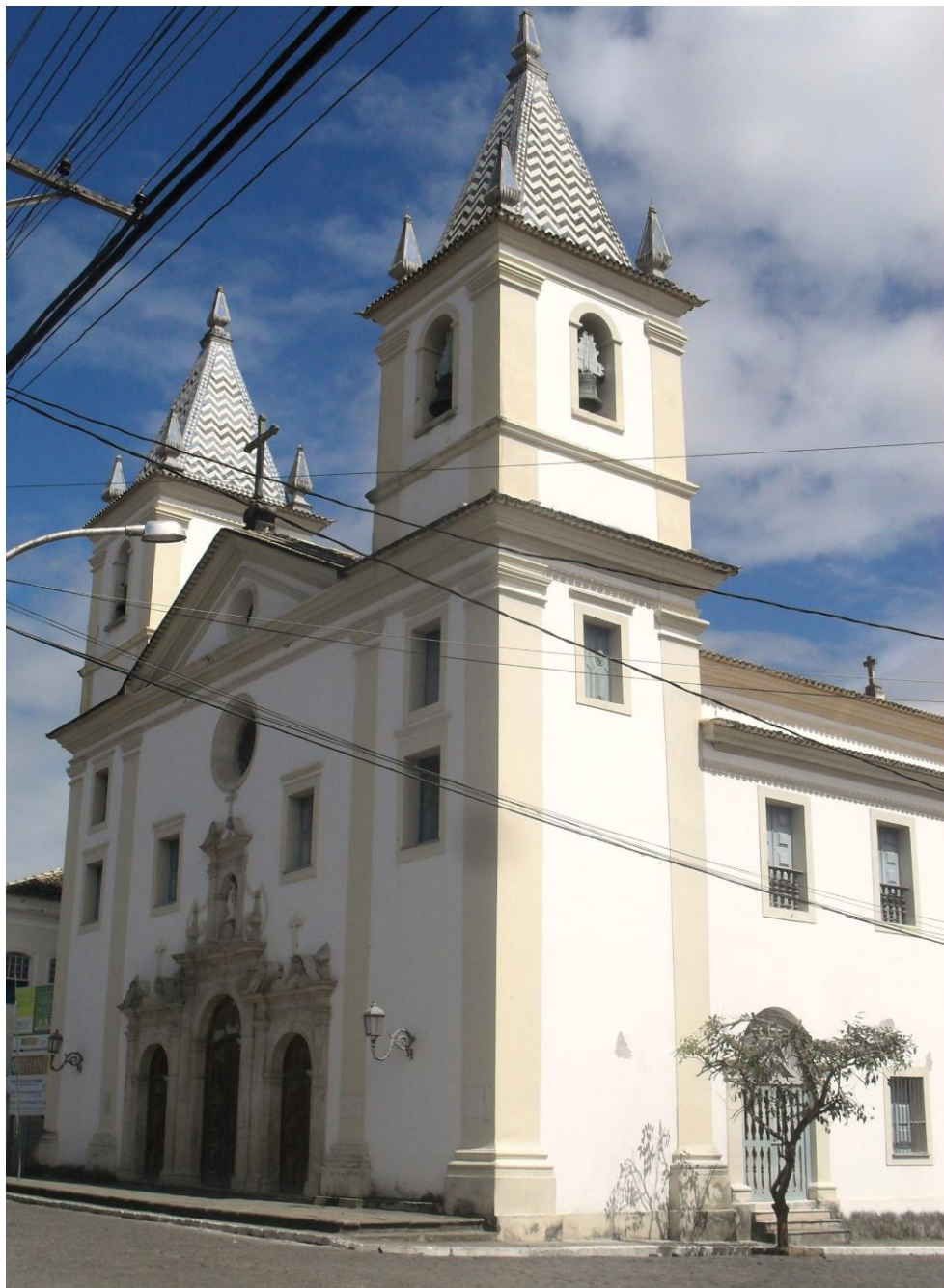
Figura 15 – Visão da fachada da Igreja Matriz da cidade de Cachoeira - BA Fonte: Acervo de Eliezer Francisco de Santana, 2011.
