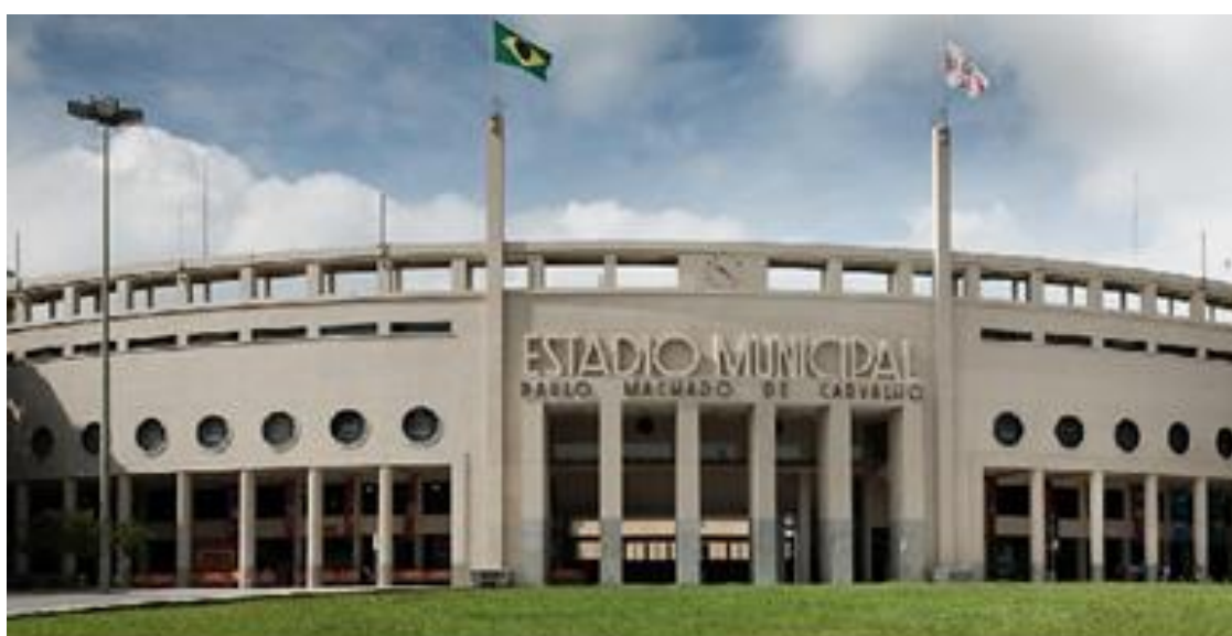
Figura 2 – Edifício frontal do Estádio do Pacaembu. Fonte: Museu do Futebol, 2014, Online 41
