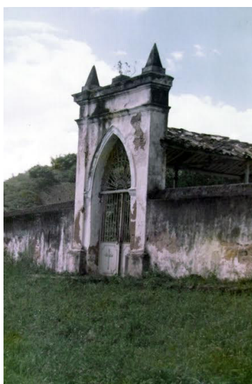
Figura 01- Fachada do cemitério com cobertura
