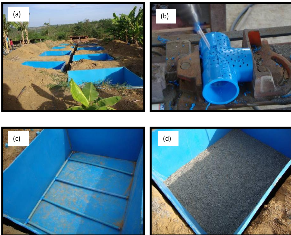
Figura 1. Vista da área experimental. Conjunto Lisimétrico (a), Construção do sistema de Drenagem com tubos de PVC perfurado (b), Montagem do sistema de Drenagem (c), camada de brita acomodada sob o sistema de tubos perfurados (d).
