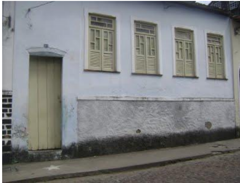
Figura 5 - Casa Estrela Foto: (MACHADO, 2010)
