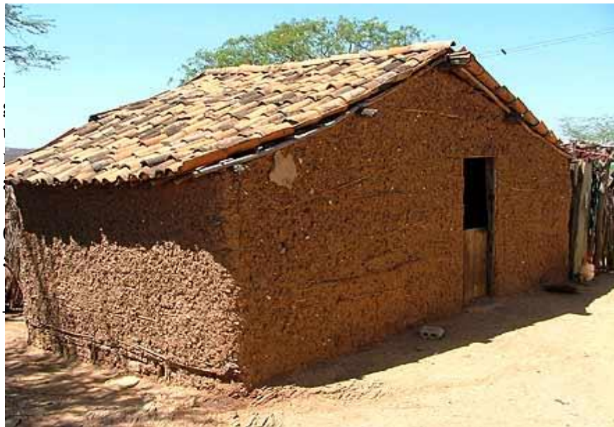
Figura 16- fotografia adquirida durante a pesquisa – Casa de barro pisado com varas na localidade do Pau Ferro em São José de Itaporã - 2012.
