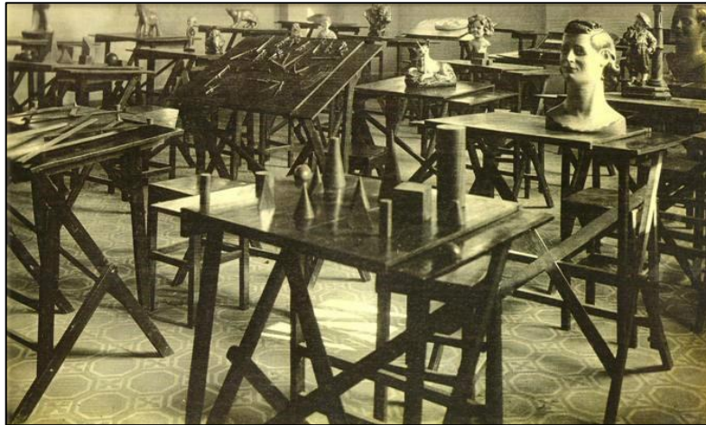
Figura 6 – Sala de Artes do Colégio Ginásio Santanópolis.
