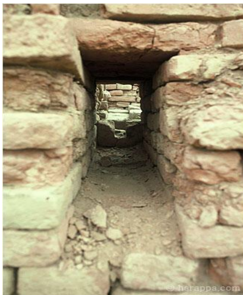
Figura 4: Vista de perto da saída de drenagem
