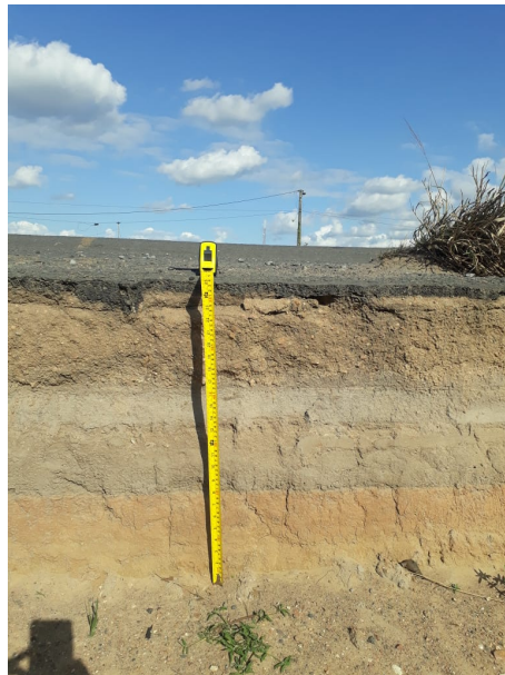
Figura 3: Espessuras das camadas do pavimento da BR-116/BA
