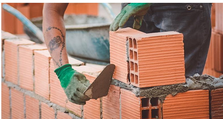
Figura 2: Alvenaria de blocos cerâmicos.
