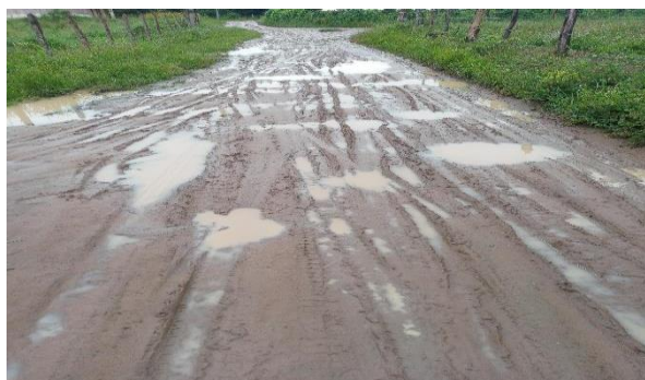
Figura 9: Condições das estradas de Povoado Umbuzeiro em épocas chuvosas
