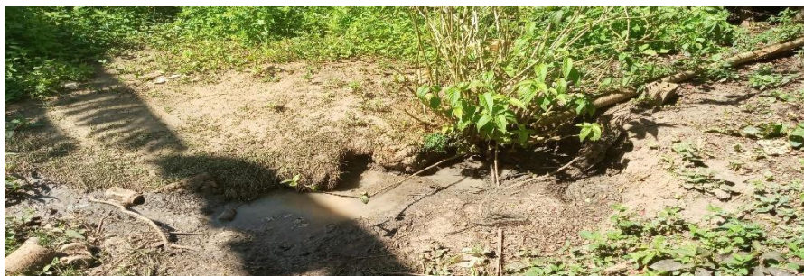
Figura 8: Drenagem de águas cinzas
