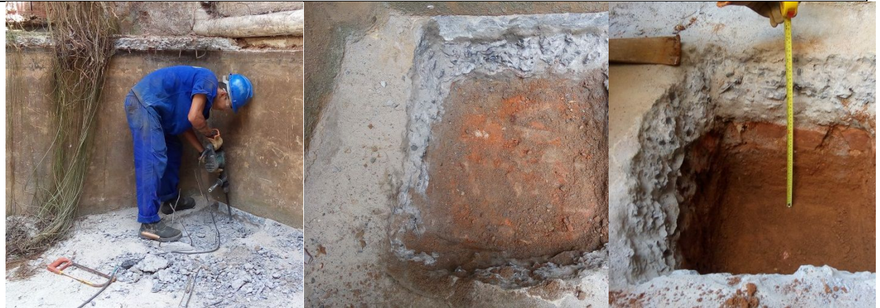
Foto 01 – Sondagem 01 sendo retirado o piso e o contra piso.
