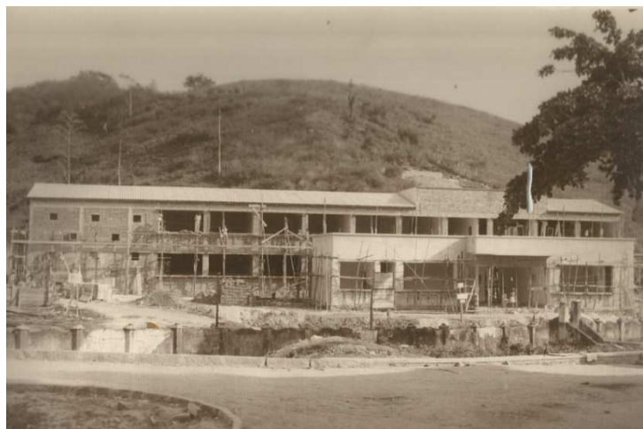
Figura 1 – Construção do Pavilhão Ernesto Simões Filho em fase de acabamento– Ano 1952 Fonte: Arquivo do CEC
