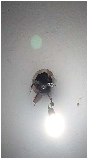
Figuras 26, 27, 28- Instalações elétricas inadequadas nas salas de guarda (Sala guarda 3 e sala de trabalho do Projeto) Ano 2018 – Fotos: Renata Teles
