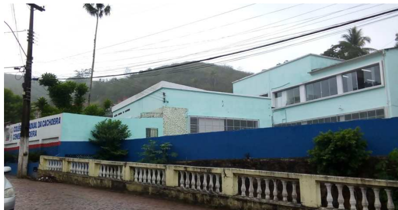
Figura 8 - Fachada do CEC e ao fundo prédio do Pavilhão Ernesto Simões Filho – Ano 2018 Foto: Renata Teles
