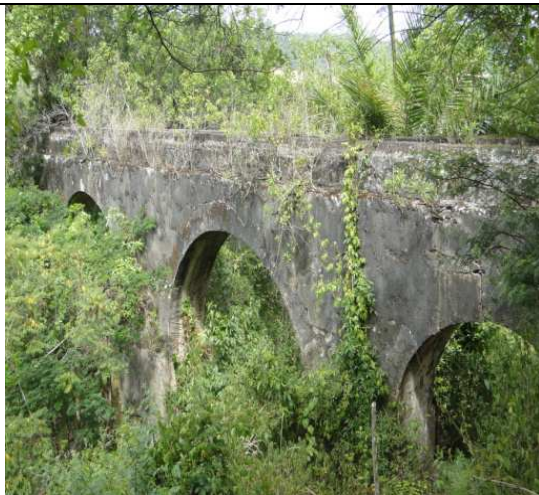
Figura 25. Estrutura atual do aqueduto Fonte: Renata Ramos 2012
