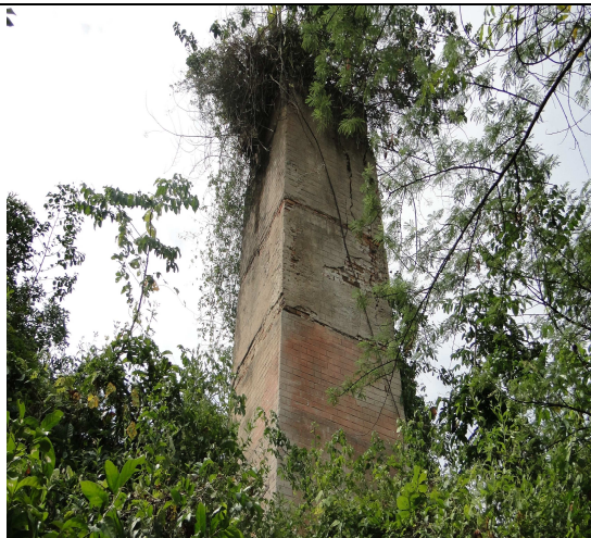
Figura 26. Chaminé utilizada pela fábrica de açúcar. Fonte: Renata Ramos 2012
