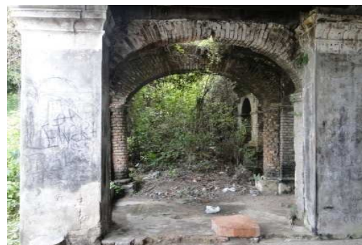
Figura 40. Estrutura da capela - vista interna da cúpula e abóbada em seu estado atual.
